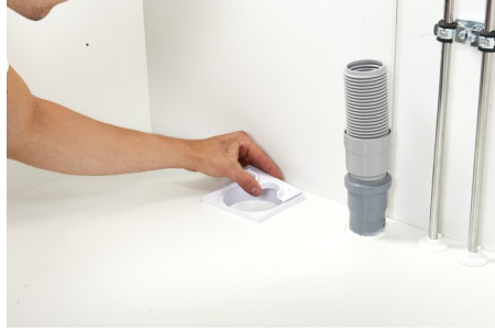
5. Aseta pienempi kansi paikoilleen pohjan takaosaan
