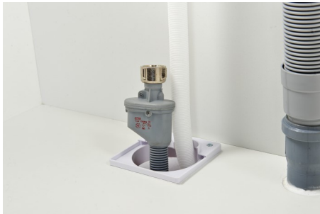
7. Tuo poisto- ja tuloletkut (magneettiventtiili) läpiviennin läpi
