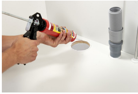
2. Laita silikonilla huolellisesti aukon ympärille
