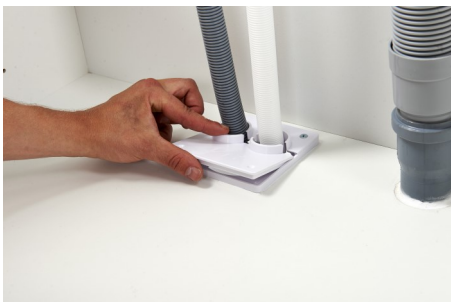
10. Aseta suurempi kansi 45° kulmassa paikoilleen
